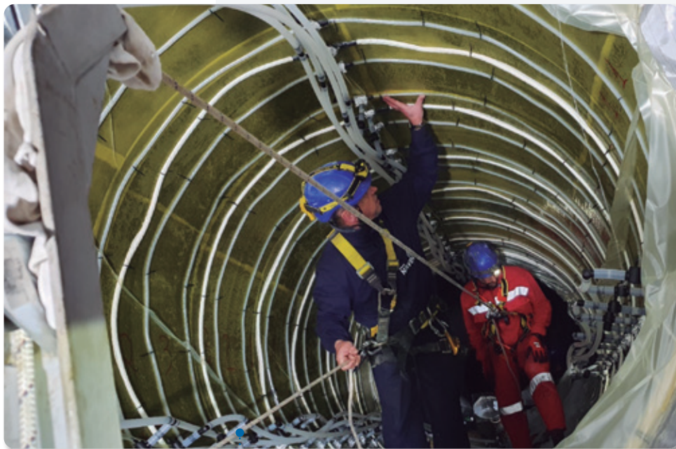
Figura 4. Sistema de infusión y vacío en tramo inclinado de sifón DN 1600 mm Figure 4. Vacuum infusion system in inclined section of siphon with diameter of DN 1600 mm
