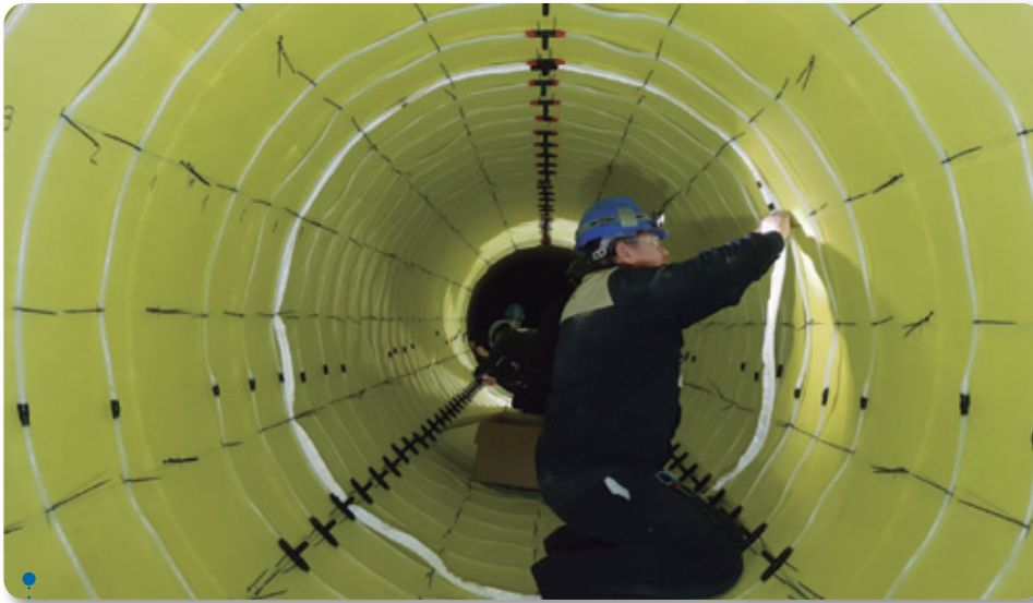
Figura 2. Proceso de colocación del sistema automatizado en tubería de agua potable | Figure 2. Installation of automated system in a drinking water pipe
