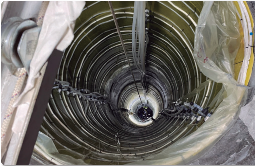
Figura 5. Sistema de infusión y vacío en tramo vertical de sifón DN 1600 mm Figure 5. Vacuum infusion system in vertical section of siphon with diameter of DN 1600 mm
